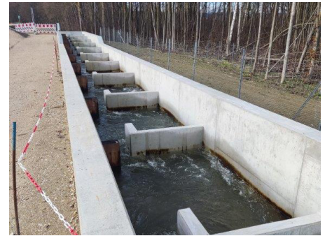
Die neue Fischtreppe – hier kommen jetzt auch die Fische wieder gut nach oben!
